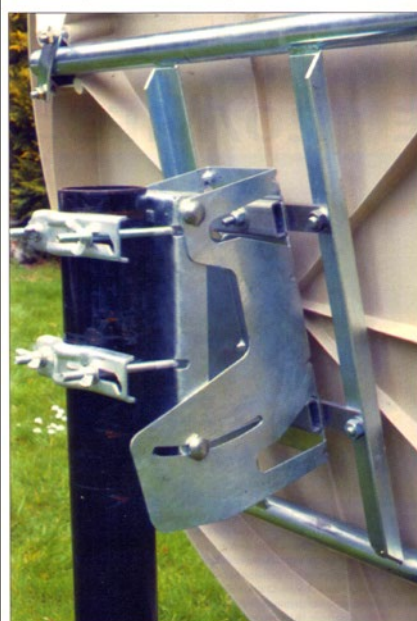
Mount der 120-cm-Antenne für 76-mm-Rohr
